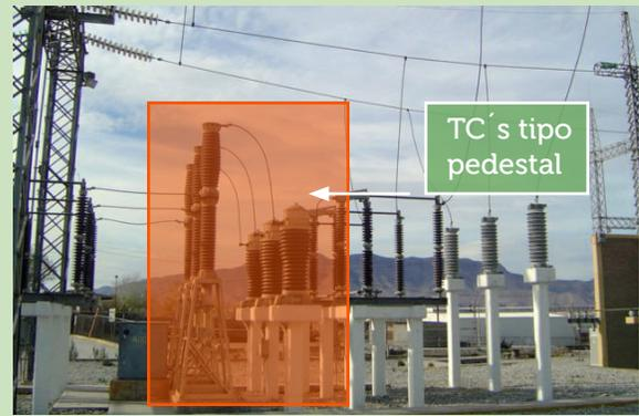
Figura 26. Transformador de corriente en pedestal
